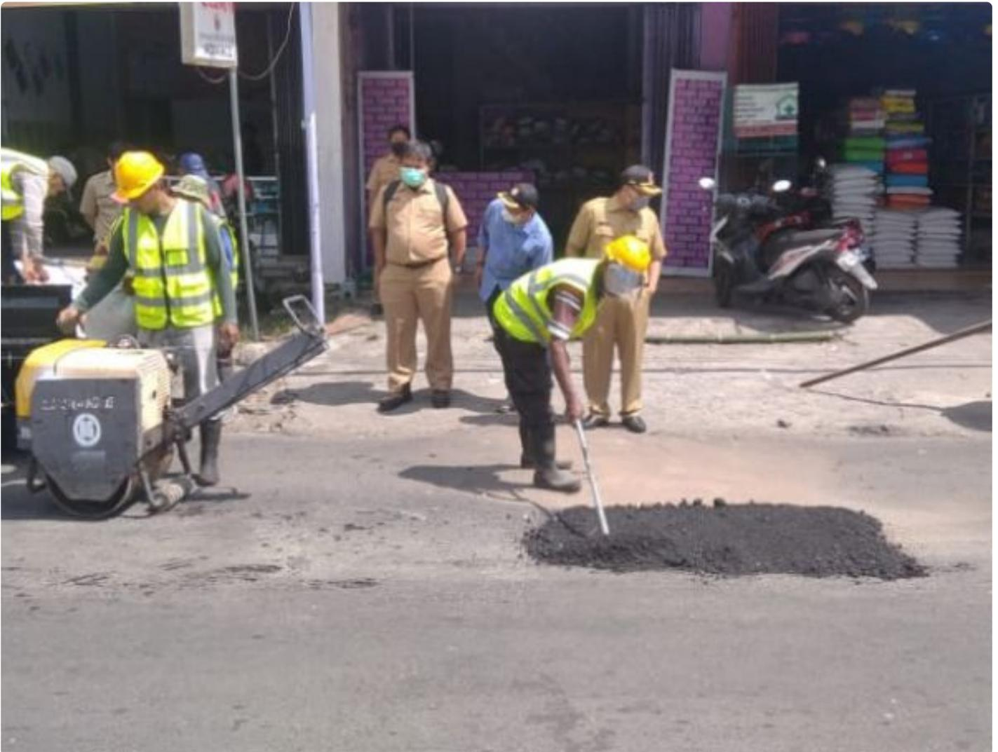
**JEMBER** - Dinas Pekerjaan Umum Bina Marga (PUBM) Kabupaten Jember melalui Tim Jalan Lubang (TJL) Satgas PU Bina Marga melakukan penambalan Jalan Aspal yang berlubang, berlokasi di Jalan Mastrip - Jalan Jawa, Selnin (12/04/2021).
